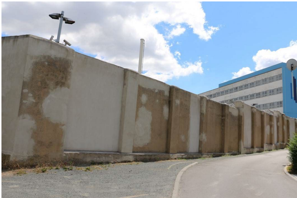
Die historische Gefängnismauer, so, wie sie zu DDR-Zeiten existierte, zieht sich um den gesamten Komplex der JVA. Heute wird das Gelände vor allem durch den inneren Sicherheitszaun gesichert. Foto: Stefanie Falkenberg
